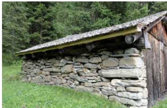
Trockensteinmauern sind ohne Zement oder Mörtel gebaut, sind sehr stabil und passen sich harmonisch ins Landschaftsbild ein.
