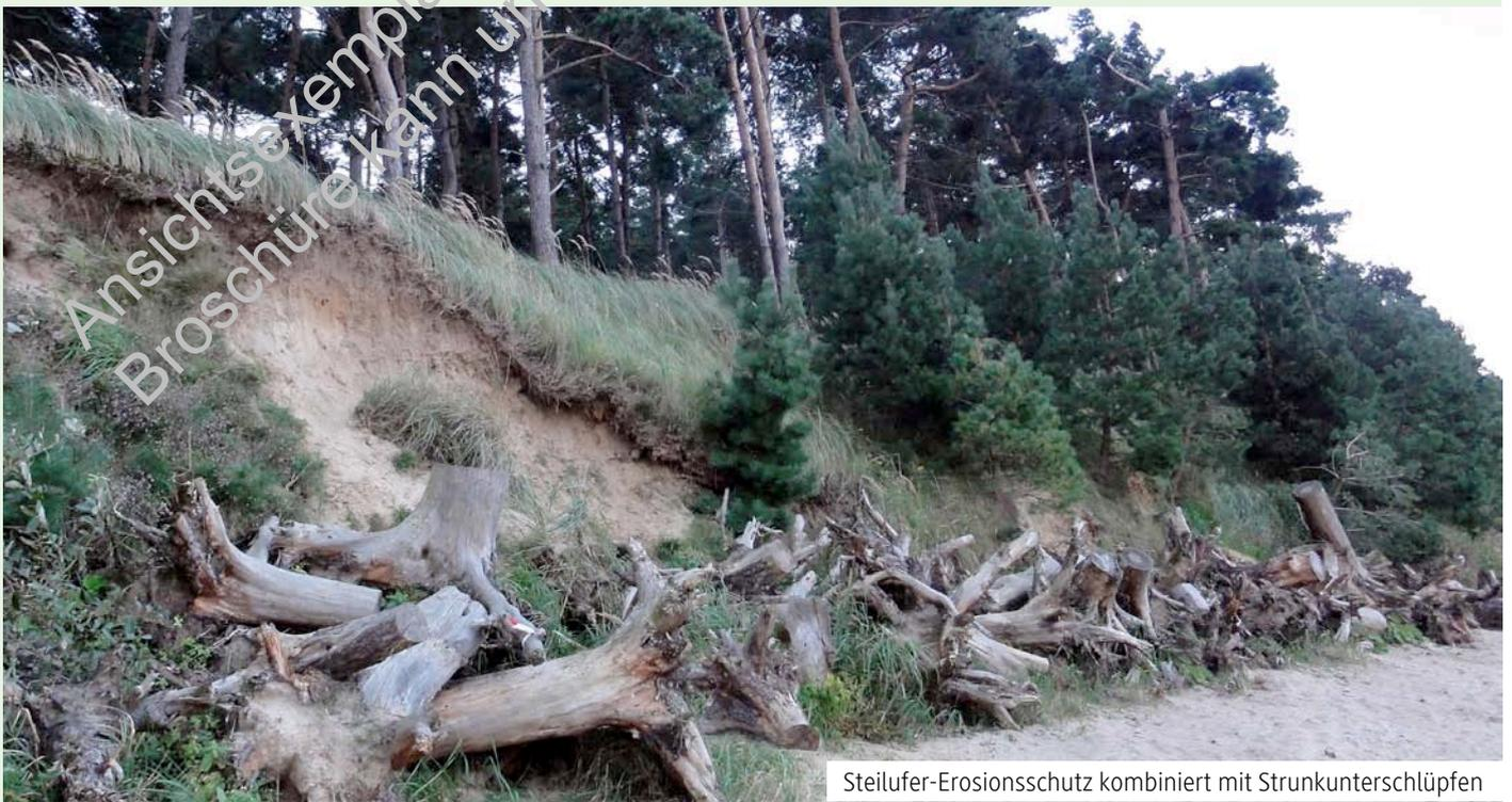
Steilufer-Erosionsschutz kombiniert mit Strunkunterschleüpfen
