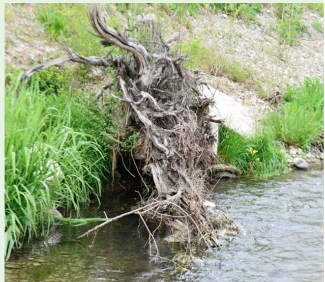
Mit Baumstrüngen können Bruthabitate und Unterschlüpfe vielfältig gebaut werden. Wenn man zwei Meter Stumpflänge belässt, können sie sicher in der Böschung verankert werden.
