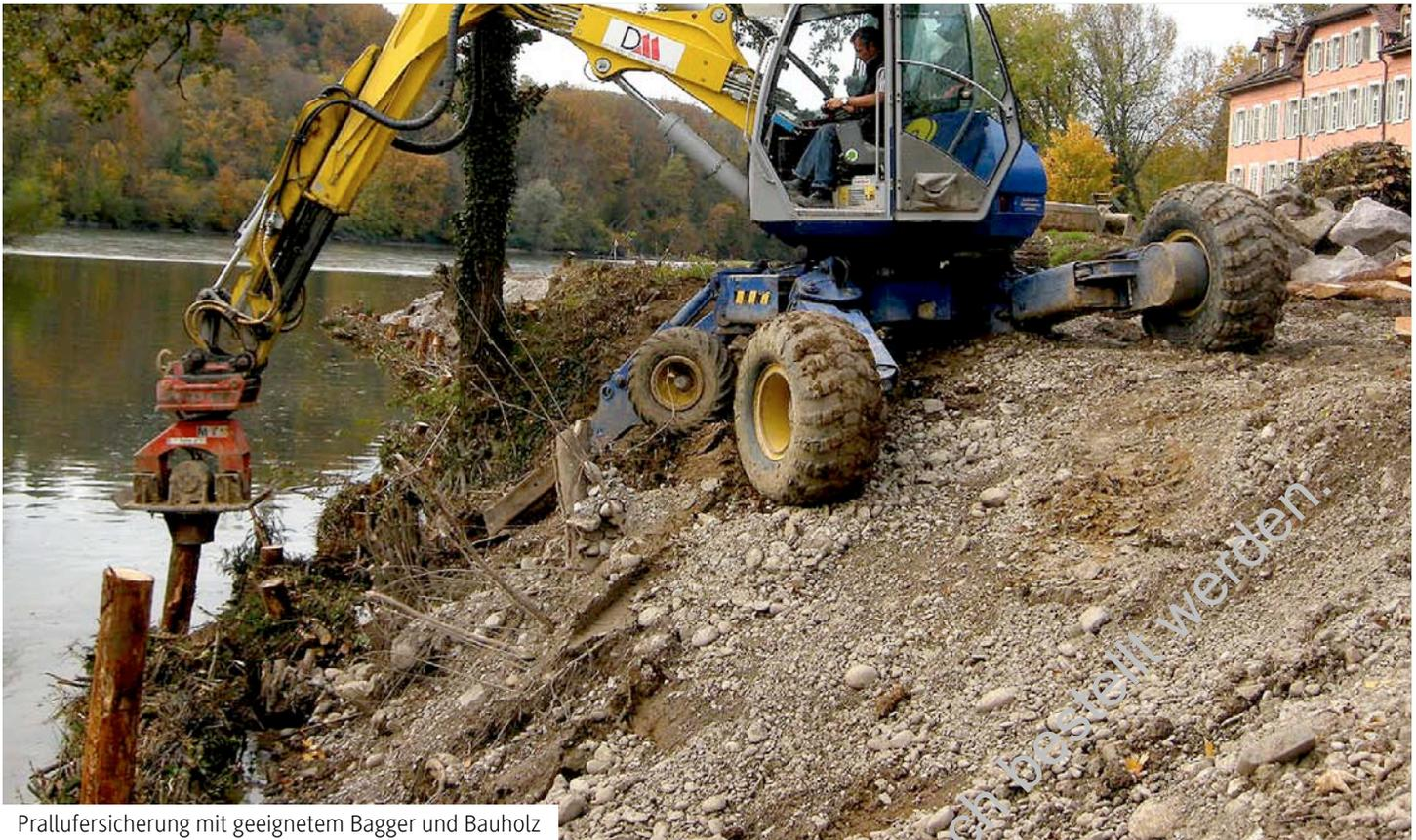
Prallufersicherung mit geeignetem Bagger und Bauholz
