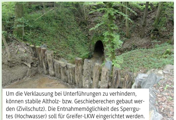
Um die Verklausung bei Unterführungen zu verhindern, können stabile Altholz- bzw. Geschieberechen gebaut werden (Zivilschutz). Die Entnahmemöglichkeit des Sperrgutes (Hochwasser) soll für Greifer-LKW eingerichtet werden.
