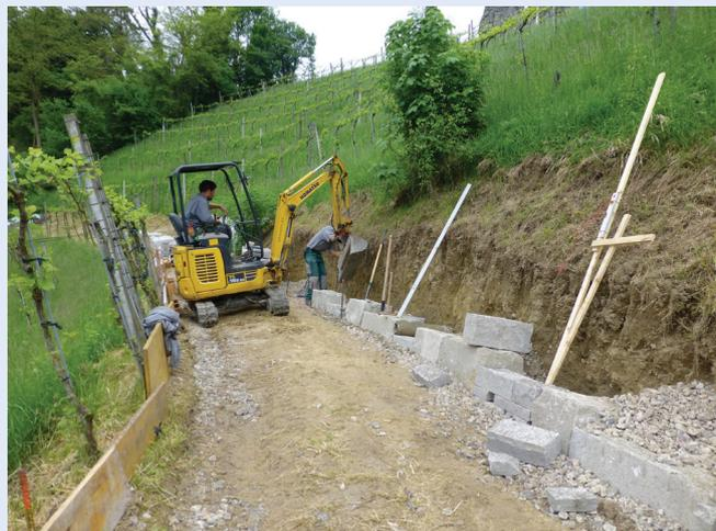
Abb. 12: Ausrichten der Fundamentsteine mit dem Bagger.
