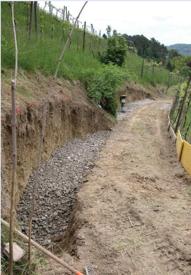
Abb. 10: Fundament aus Schotter.
