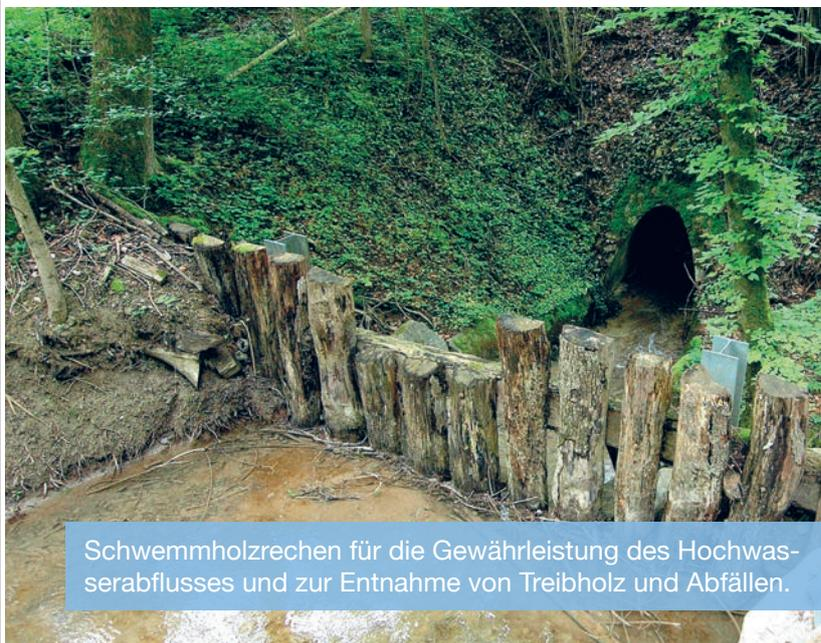
Schwemmholzrechen für die Gewährleistung des Hochwasserabflusses und zur Entnahme von Treibholz und Abfällen.
